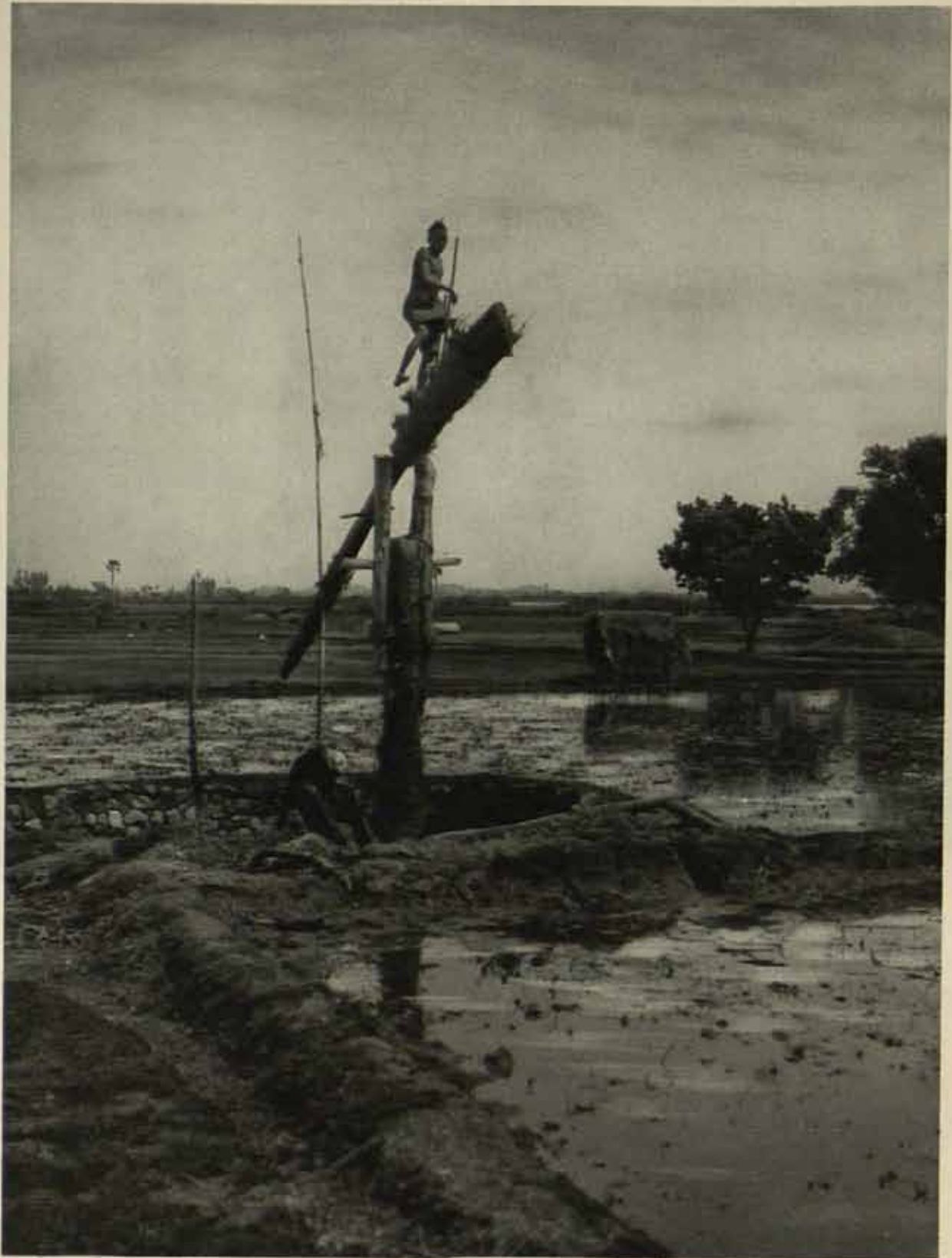
Bewässerungsanlage bei Chingleput
