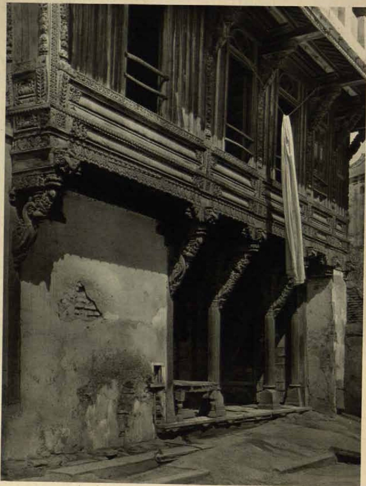
Ahmedabad. Haus mit Holzschnitzerei
