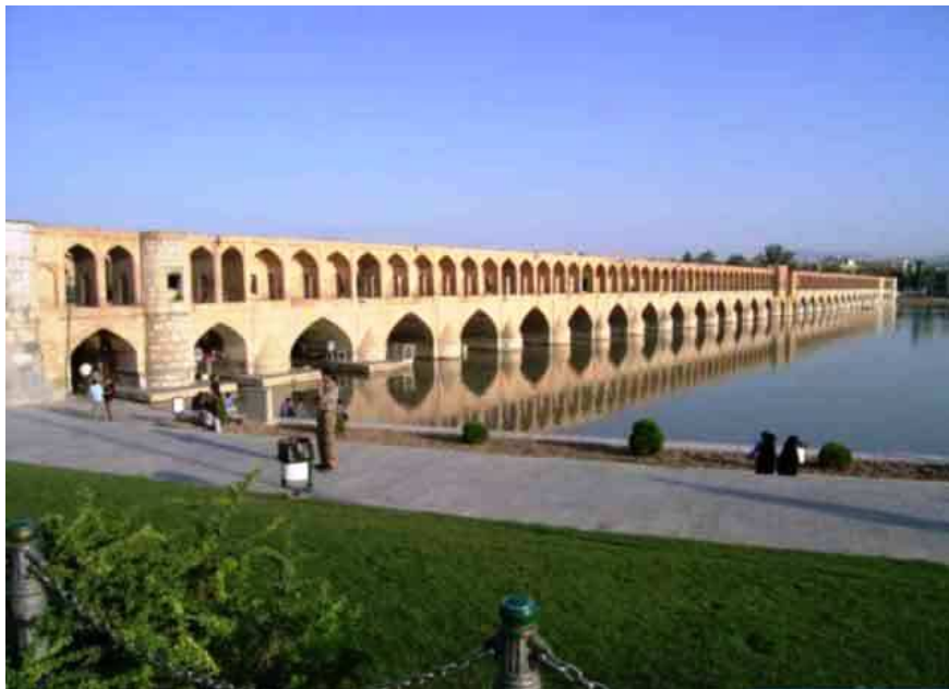
63. Allah Verdi bridje,Isfahan
